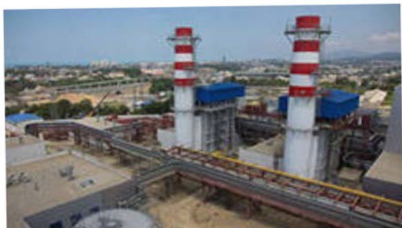
Строительство Адлерской ТЭС установленной электрической мощностью 360 МВт
