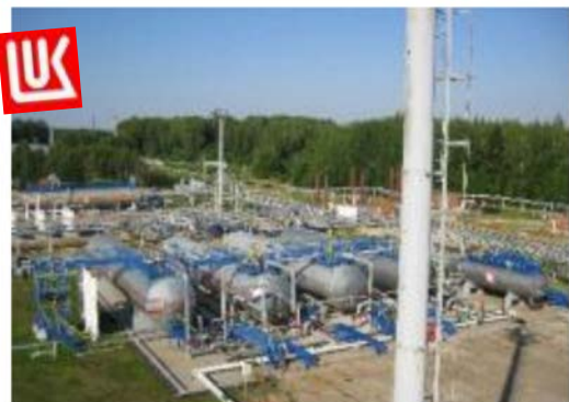
Строительство газового нефтепровода ЛУКОЙЛ-ПЕРМЬ
