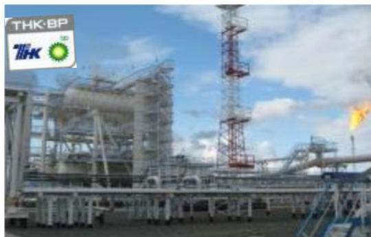
Строительство площадочных объектов и технологических-промысловых трубопроводов ТНК-ВР
