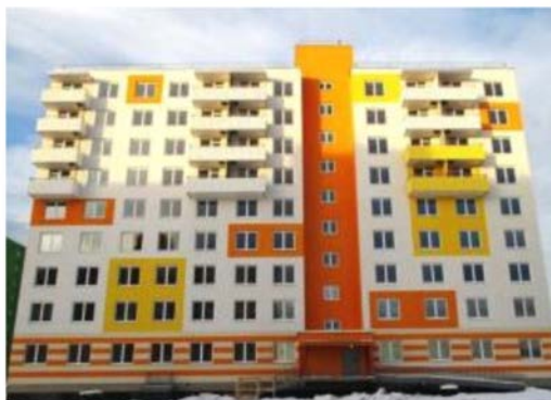
Строительство жилого комплекса «Любимов», г. Березники
