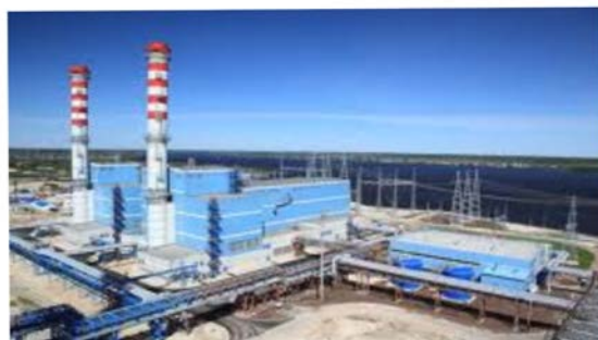
Строительство Яйвинской ГРЭС мощностью 400 МВт
