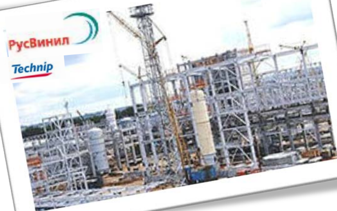
Строительство комплекса по производству ПВХ
