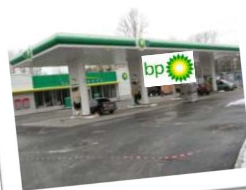
Строительство автозаправочных комплексов
