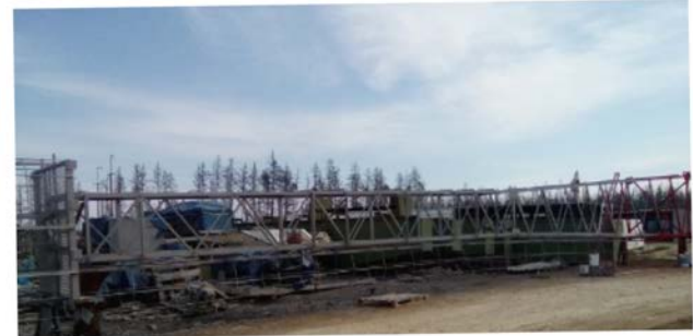
Объект капитального строительства Иркутская область. Строительный контроль АО «Верхнечонскнефтегаз»
