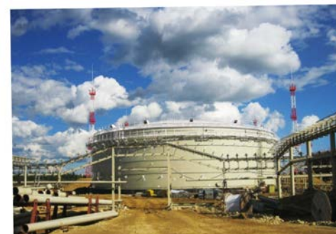
Строительство нефтепровода «Куюмба - Тайшет», «Красноярск - Иркутск», «Омск-Иркутск»
