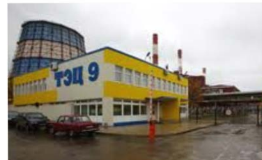
Строительство блока ПГУ установленной электрической мощностью 165 МВт на Пермской ТЭЦ-9
