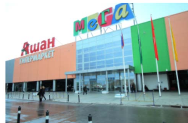
Реконструкция ТЦ МЕГА, г. Нижний Новгород
