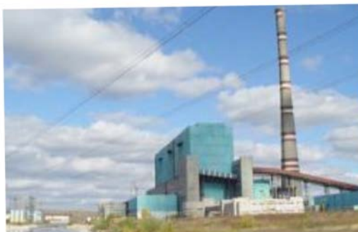
Строительство энергоблока № 3 на базе ПСУ-800 Берёзовской ГРЭС
