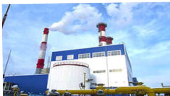
Строительство ПГУ установленной электрической мощностью 120 МВт на Пермской ТЭЦ-6
