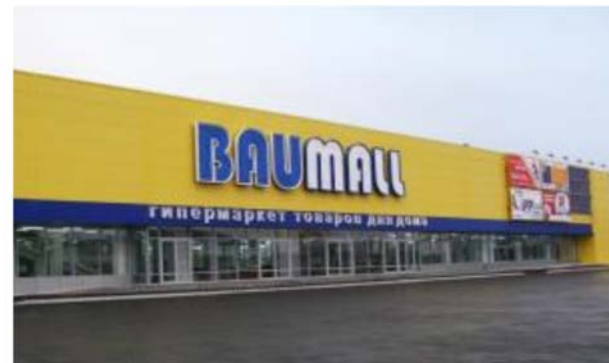
Реконструкция ТЦ BAUMALL
