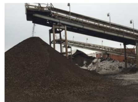
Строительство дробильно- сортировочной установки
