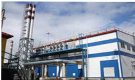
Строительство ТЭС «Полярная»
