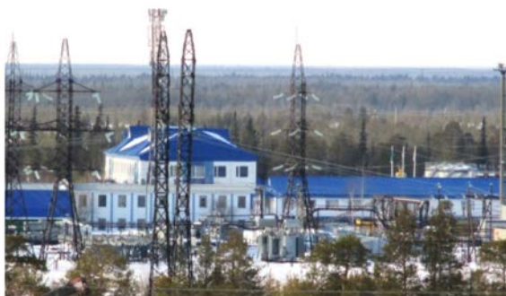
Строительство объектов добычи, подготовки и транспорта нефти г. Радужный
